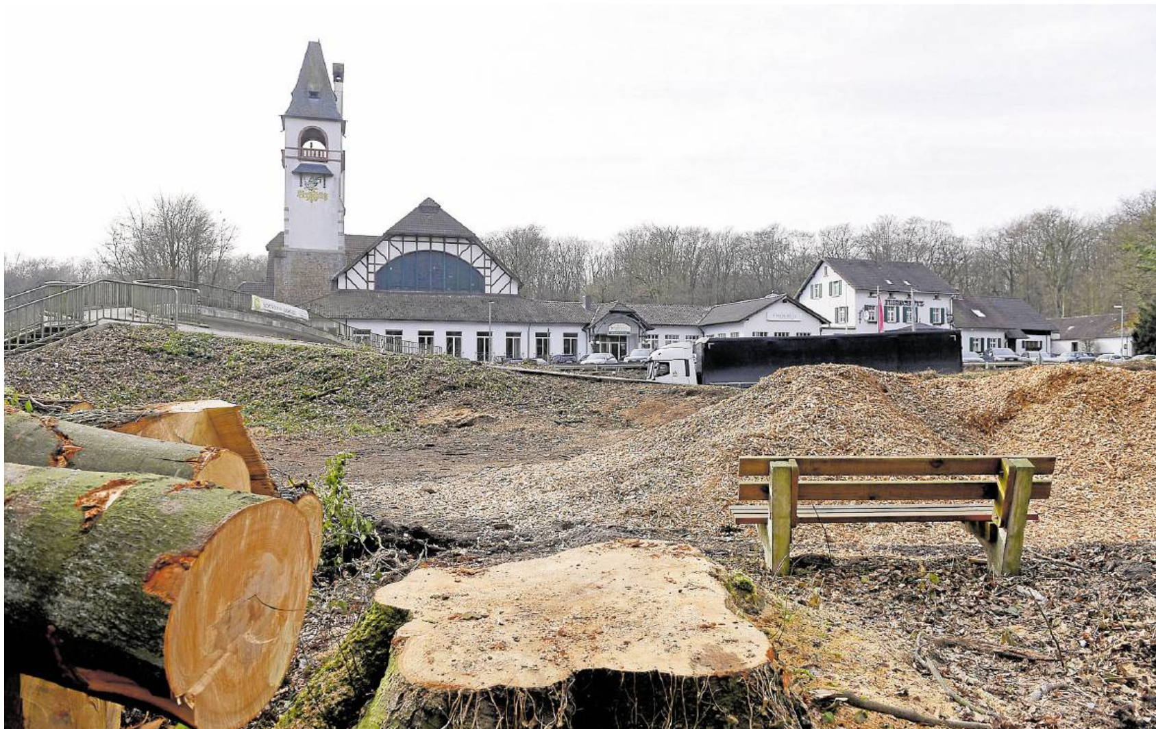
An der B236 wurden in Höhe des Restaurants Freischütz für den Ausbau und die Brückenerneuerung die angrenzenden Bäume gerodet.
